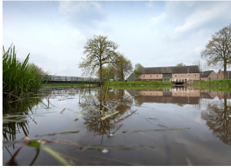
Het afwateringskanaal dat om de molen heen is gegraven i.v.m. de ruilverkaveling in de jaren zestig
